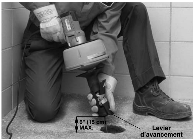
Figure 10 – Avancement du câble à l'aide du système AUTOFEED
